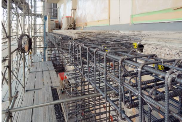
既存塗装のアスベスト撤去後、解体+配筋
