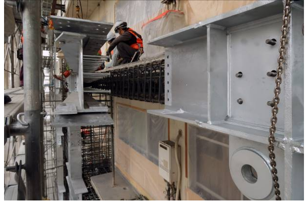
フレーム先端に鉄骨ブレース設置
