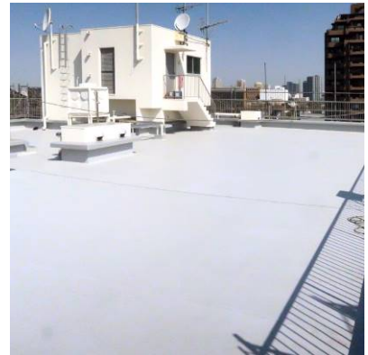
外断熱シート防水(軽量化)完了
