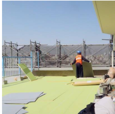
押えコン撤去後、断熱材敷設
