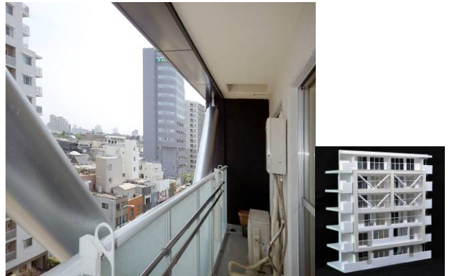
フレーム設置後のバルコニー(設計時に模型棟で検討)
