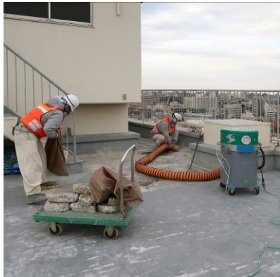
■屋上軽量化工事(補助金対象)
