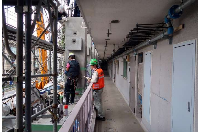
P C 部材 組立作業 2
