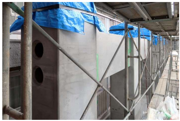
P C 部材 組立作業 3
