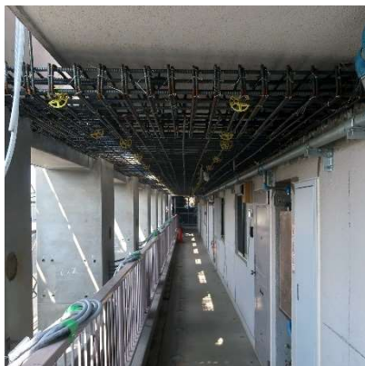
接続スラブ配筋
