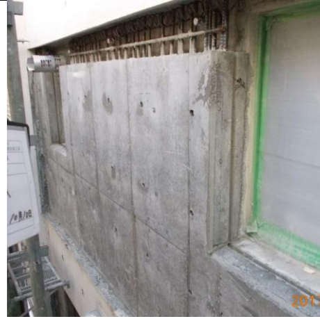
北側外壁増し打ち壁打設
