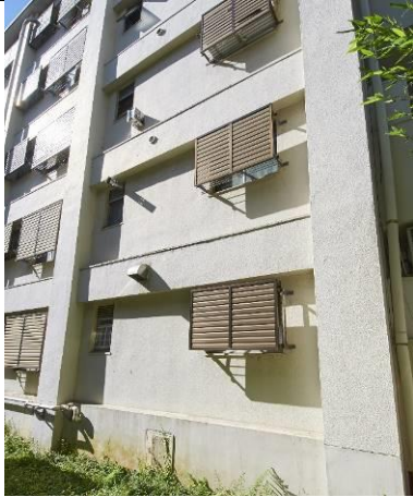
北側外壁増し打ち 改修前
