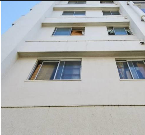
構造スリット新設 改修前
