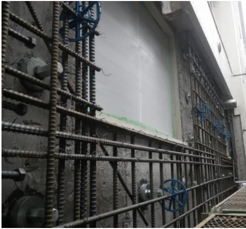
北側外壁増し打ち壁配筋
