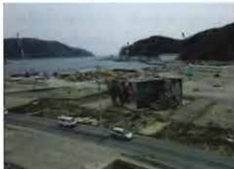
放置されたビルの残骸
