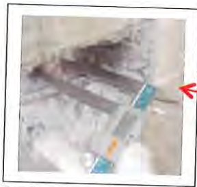
柱主筋の計測 かぶり厚も計測
