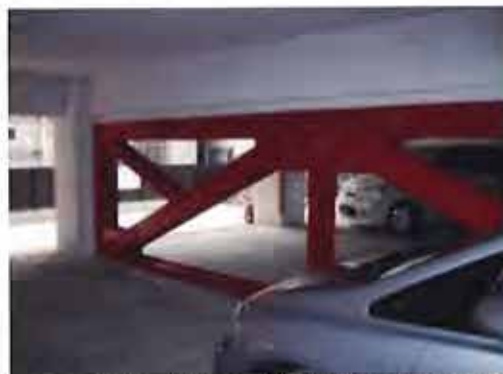
写真1 駐車場の補強 まず共用部分から補強を始める
