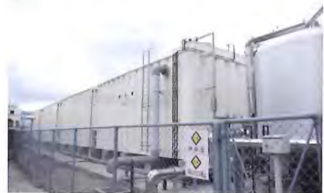
写真1 鋼板製一体型は被害がなかった(仙台市内)
