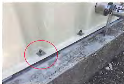
写真 14 コンクリート基礎へアンカーボルトで固定
