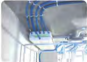
(36ℓ、断熱有り、吸気弁内臓) 写真 18 天井裏設置例
