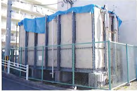
写真4 天板の破損
