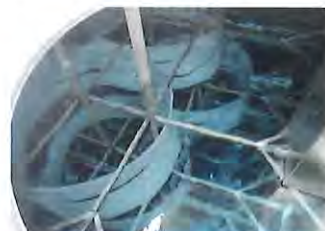
写真 15 神奈川県 Zマンション設置例
