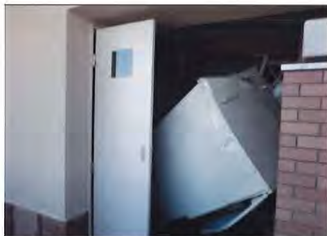
写真 12 転倒した電気温水器が廊下の避難通路を塞ぐ
