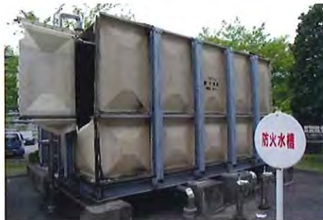
写真9 隅部上部パネルの破損
