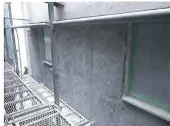
壁増し打ち工事（モルタル削り）
