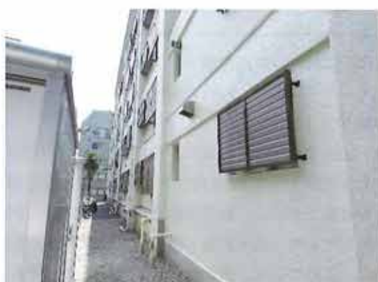
壁増し打ち (施工後)
