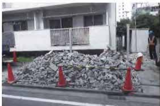
駐輪場・ブロック塀解体
