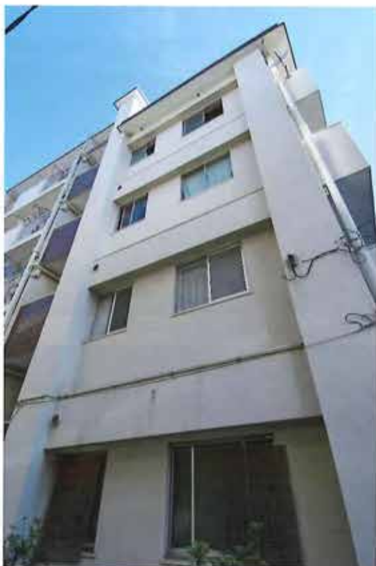
耐震スリット (施工前)
