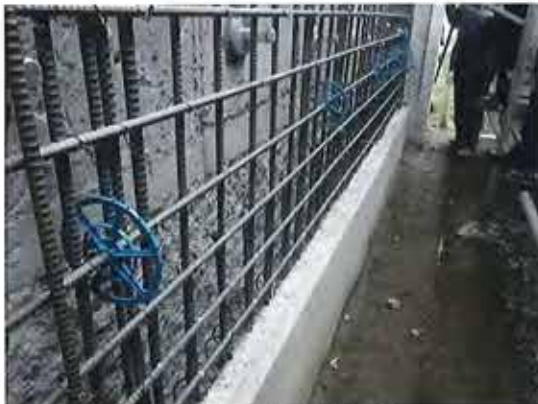
壁増し打ち工事（鉄筋配筋）
