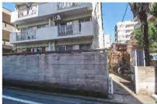
改修前の駐輪場・ブロック塀
