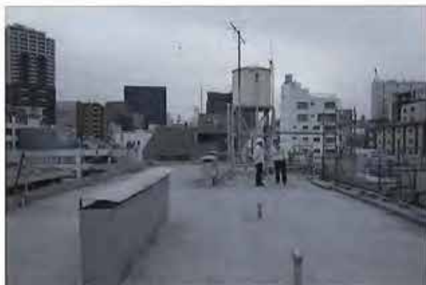
改修前屋上全景
