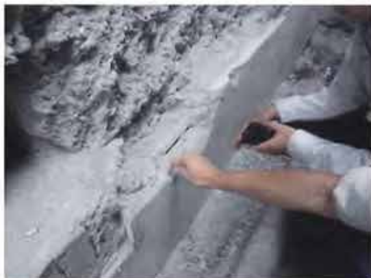
基礎梁天端の位置
