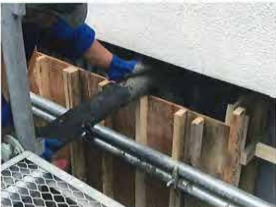
壁増し打ち工事（RC打設）
