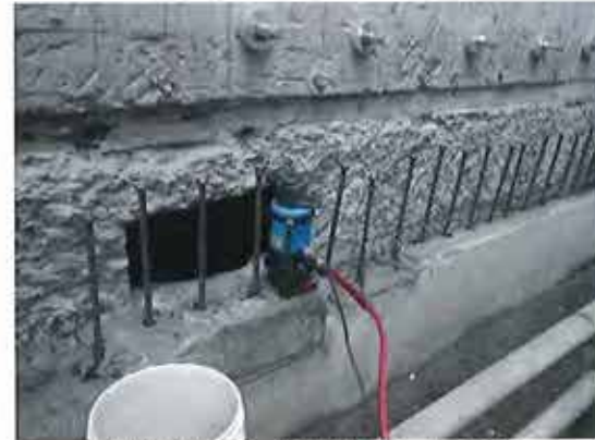
壁増し打ち工事（あと施工アンカー検査）
