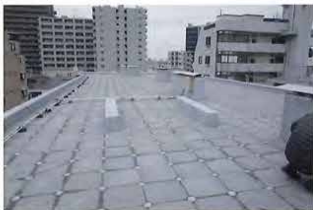
改修後屋上全景
