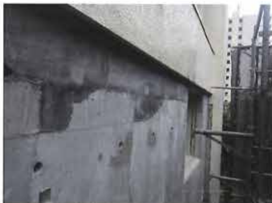
壁増し打ち工事 (RC 打設)
