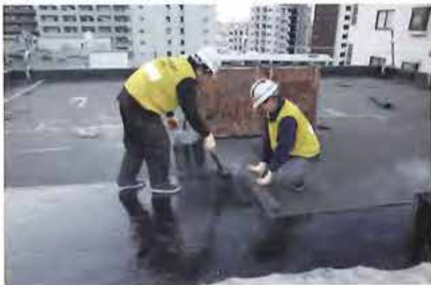
アスファルト熱工法の施工状況
