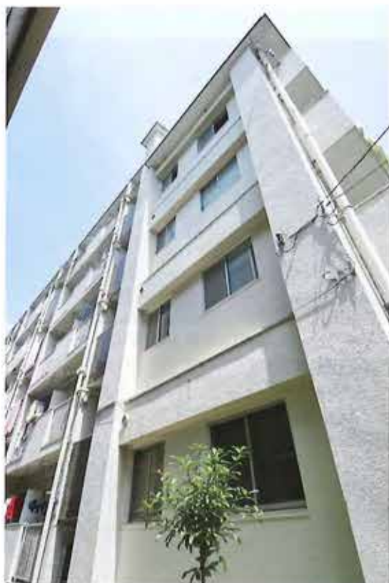
耐震スリット (施工後)
