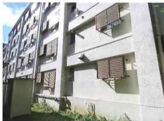
壁増し打ち (施工前)
