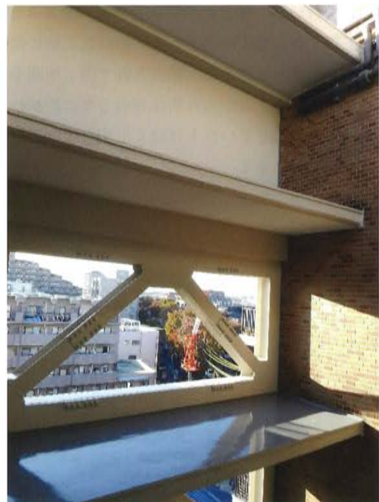
8階・9階 吹き抜け部補強
