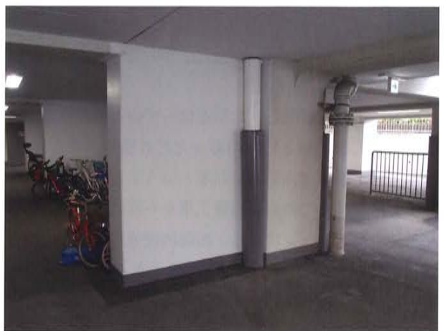
写真6 袖壁補強
