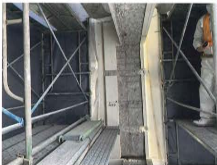
写真20 北側既存柱・梁のモルタルを除去
