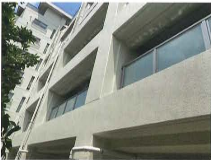
写真19 完成したアウトフレーム
