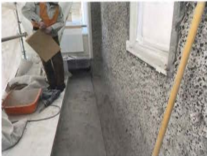
写真26 6階屋上の増し打ち壁部分、既存パラペットを解体、一部防水層を除去して、躯体を目荒らし
