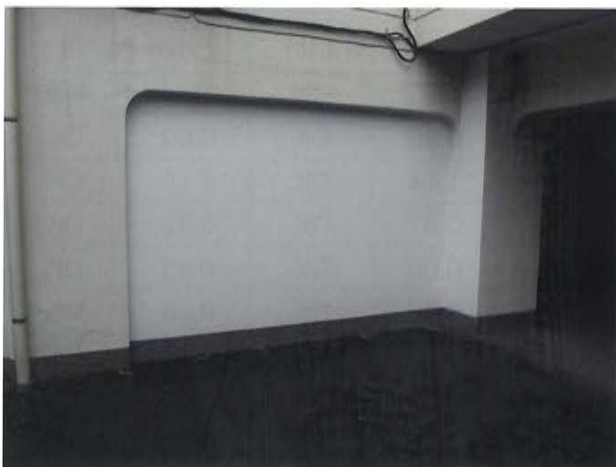
写真4 壁増し打ち箇所
