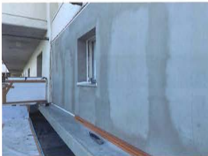
写真29 脱型 合わせてパラペットアゴも施工
