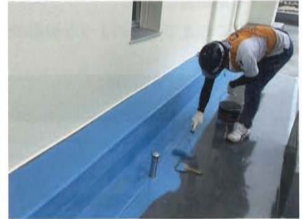
写真31 塗膜防水を施工
