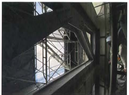
写真21 鉄骨ブレースを吊り込み設置
