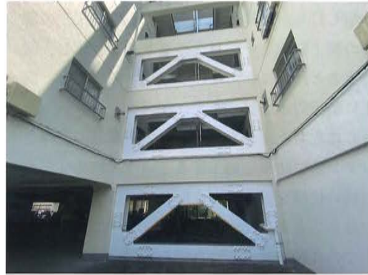
写真 35 北側鉄骨ブレース全景
