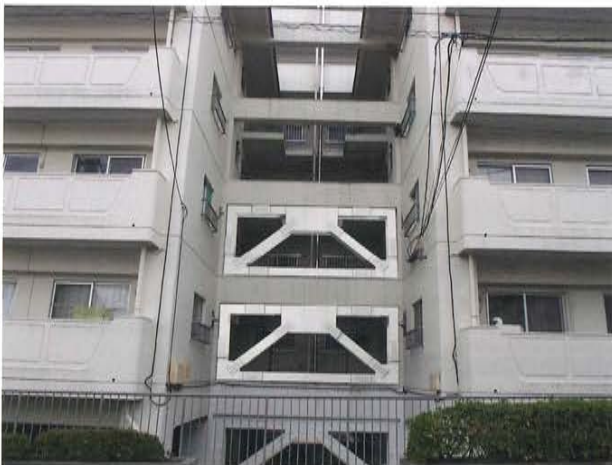
写真11 北側鉄骨ブレース取り付けイメージ 下段は1階ピロティで設置済み、中段と上段がCGによる合成
