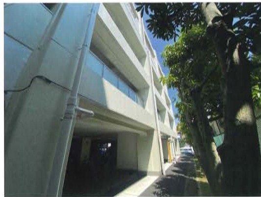
写真33 南側ビタフレーム竣工した全景
