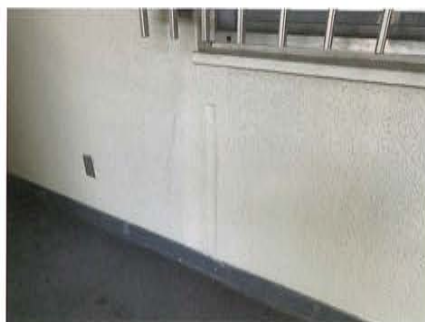
写真25 スリットに塗装し、仕上げた状態
