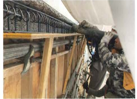
写真28 型枠を組みコンクリート打設
