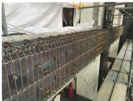
写真14 ピタフレームの鋼板と配筋設置状況
