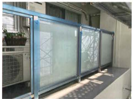
写真18 フレームの付く住戸は鋼製手すりをアルミのガラスパネル手すりに更新
