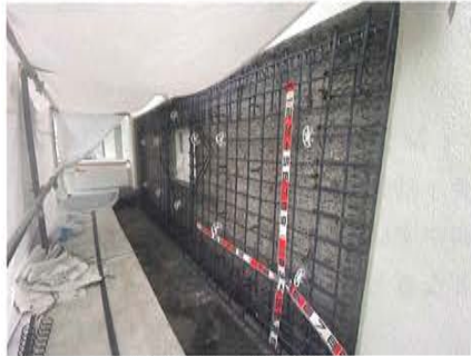
写真27 壁配筋施工
