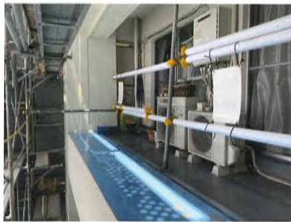
写真17 躯体に塗装・梁上には塗膜防水を施工
