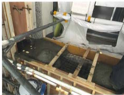
写真15 ピタフレームコンクリート打設配筋が密なので細心の注意を払って施工
