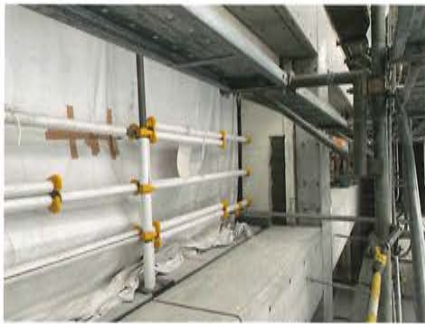
写真16 脱型した状況
