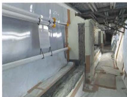
写真13 南側バルコニー前躯体解体中
