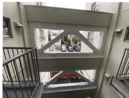
写真23 完成したブレースを廊下から見る
