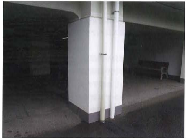
写真5 柱巻き立て補強
