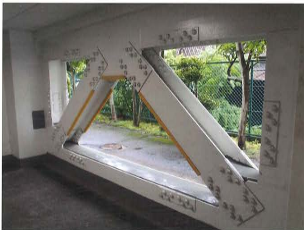
写真3 K型鉄骨ブレース補強箇所
