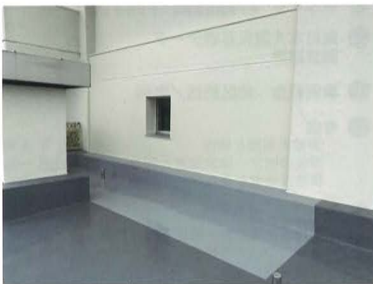
写真32 完成した増し打ち壁
