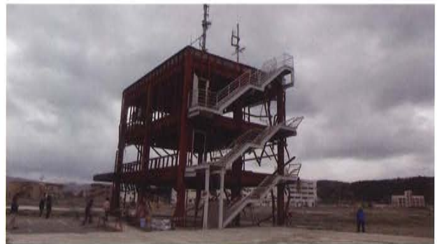
写真 15 第 7 次調査の南三陸町防災対策庁舎 (2022 年 5 月 2 日)
