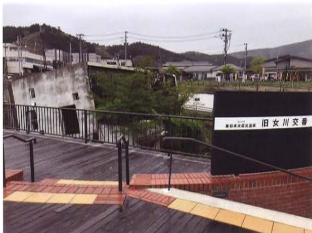
写真7 第17次調査の旧女川交番 (2022年5月1日) 女川町東日本大震災遺構旧女川交番。
