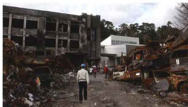
写真 1 第 1 次調査の石巻市立門脇小学校 (2011 年 5 月 2 日)
