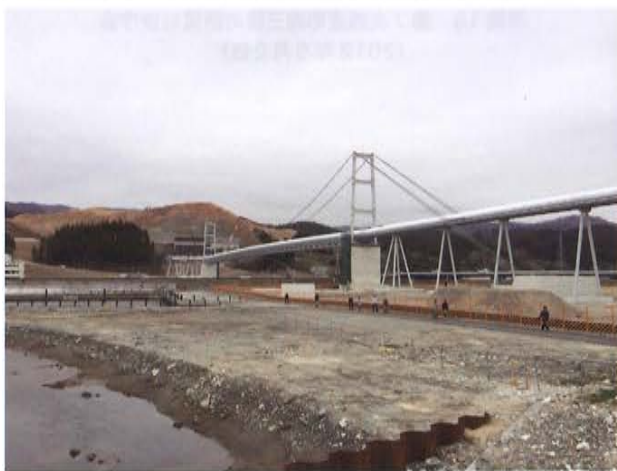
写真 18 第 11 次調査の陸前高田 今泉地区の山を切り崩し高田地区へ土を運ぶ ベルトコンベアー (2014 年 4 月 29 日)
