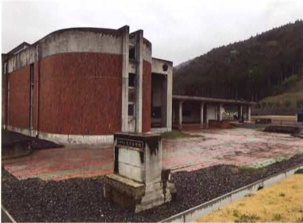
写真 12 第 17 次調査の石巻市震災遺構大川小学校 (2022 年 5 月 1 日)
