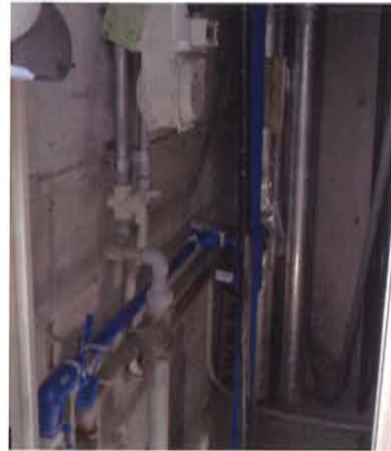
給水管の取替え
