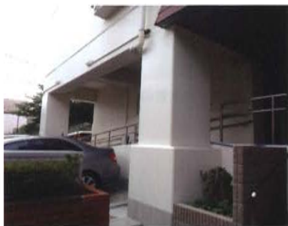
柱の巻き立て補強 (上は鉄板、下はRC)
