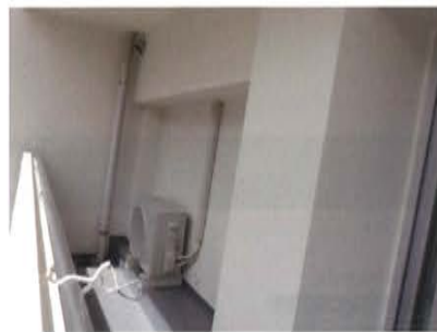
管理室外側 新設耐震壁と新設柱
