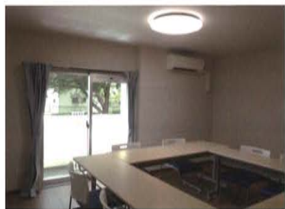
管理室内 向かって右側が耐震壁
