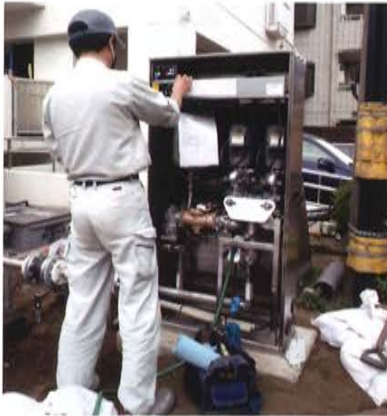
増圧ポンプ設置
