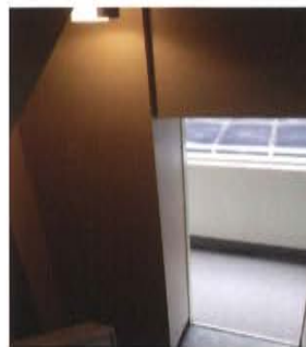
袖壁補強 (壁を梁の厚み分ふかさ)
