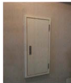
PS点検口新設
