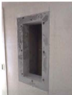
PS点検のための壁開口 (開口補強の様子)
