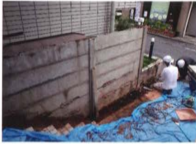
新築時以前から設置されていた万年塀
