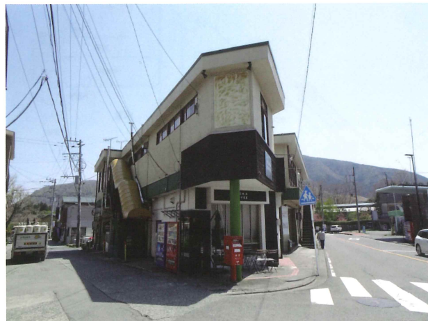
建物の右道路側が正面入口ではあるが、 裏側にある裏口を精肉店の入口として使っている。
