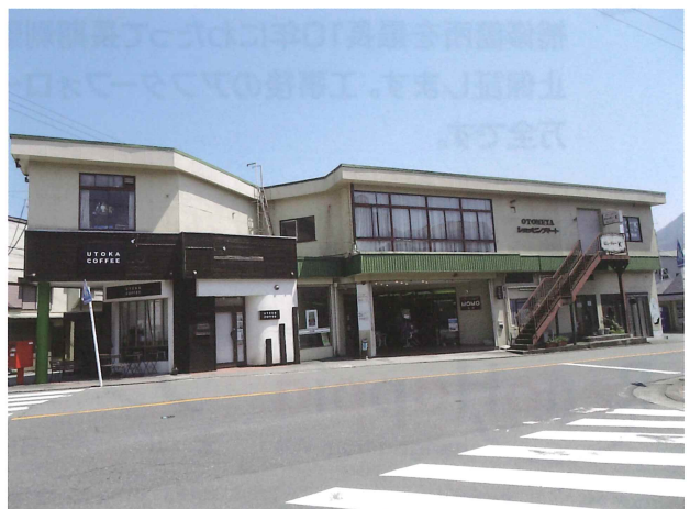
全面道路は、箱根町の一般緊急輸送道路に指定されている。
