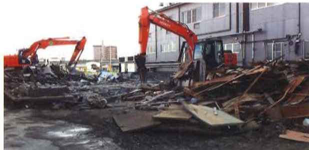
散乱する瓦礫の撤去風景
