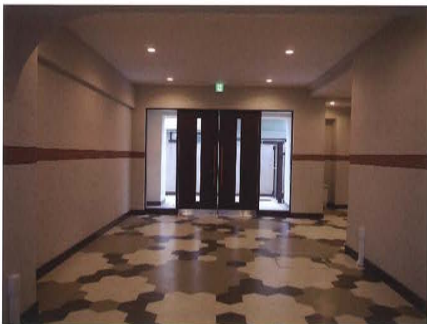
写真7 耐震壁(写真左側)ができたことでエントランス内の内装をリニューアルした。
