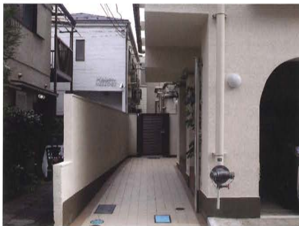
写真6 マンションへの導入路はバリアフリー化した。
