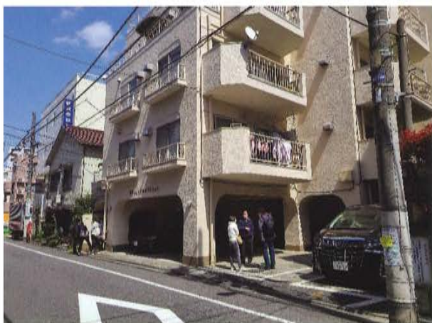
写真2 補強前のマンションエントランス
