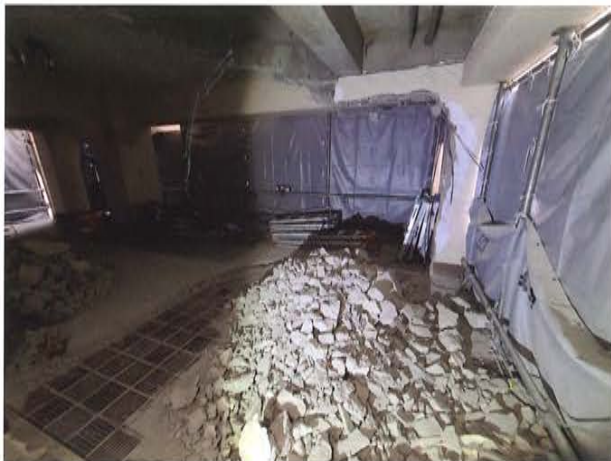
写真4 既存雑壁の解体工事
