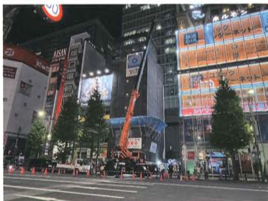
写真4 足場仮設と夜間工事の様子
