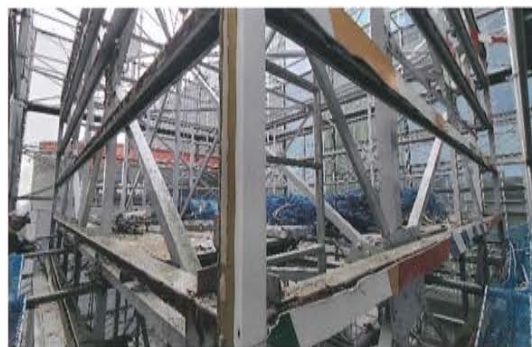
写真8 屋上看板解体の様子
