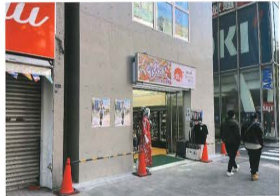
写真 17 店舗出入口には袖壁付柱フレームが新設されたが、そのフレームを意匠的に表に出した。
