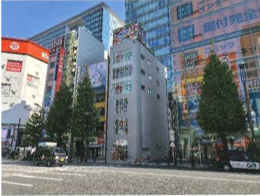
写真 14 補強工事後の第5電波ビル
