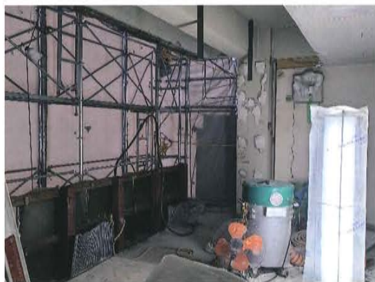
写真7 建物ファサード側の解体工事
