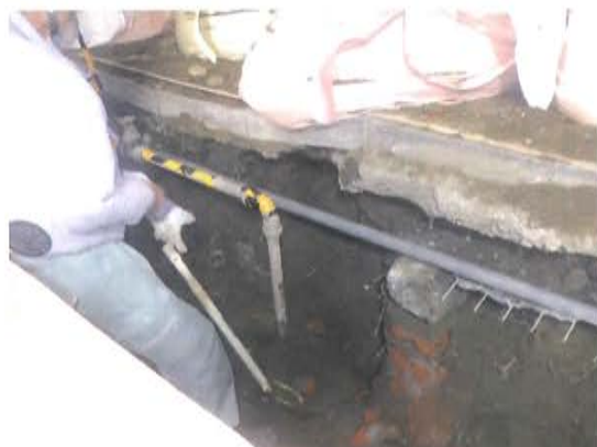
写真5 地中に古いレンガ積が出てきた。
