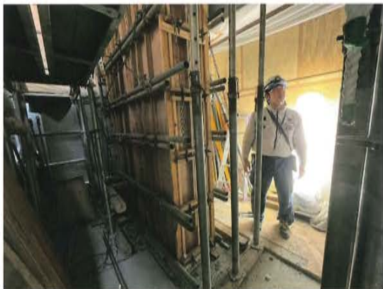
写真 12 型枠工事
