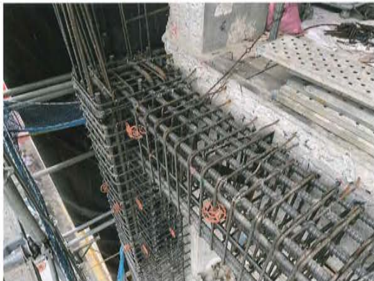
写真 11 補強部材となる柱梁フレームの配筋
