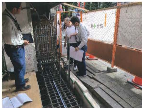
写真6 地中梁の配筋検査
