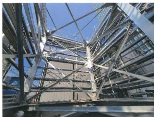
写真10 鉄骨部材が組みあがり看板下地が構成される
