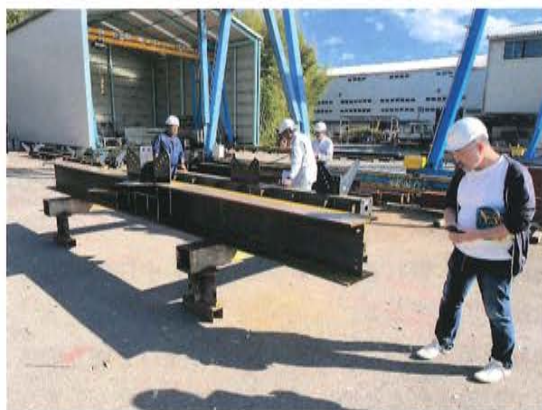
写真9 鉄骨工場検査の様子
