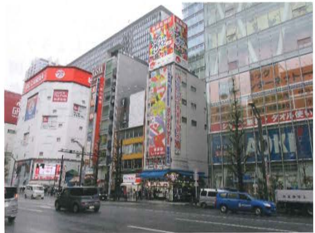
写真1 補強工事前の第5電波ビル
