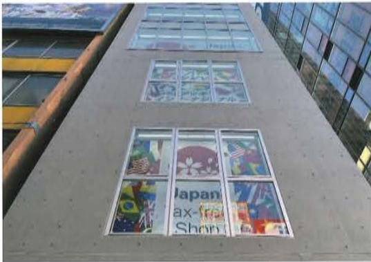
写真 16 水性フッ素塗料にてコンクリート打放しの表情とコンクリート保護を目的に塗材を選定した。
