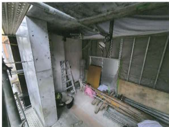
写真 13 脱型後の補強部材
