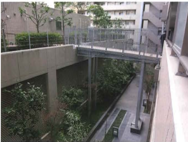
写真3 避難橋：左手は集会室がある別棟、右手は住棟
