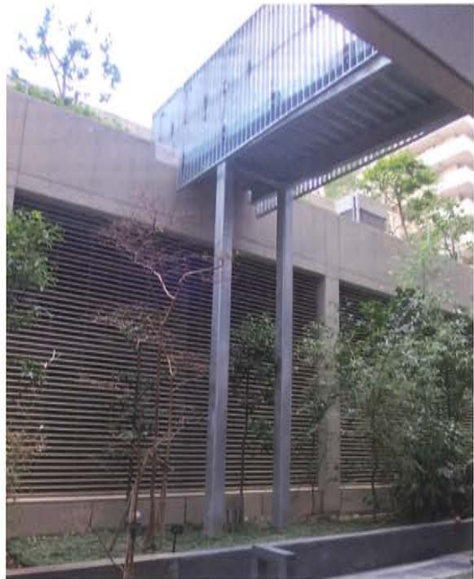
写真5 避難橋を仰ぎ見る
