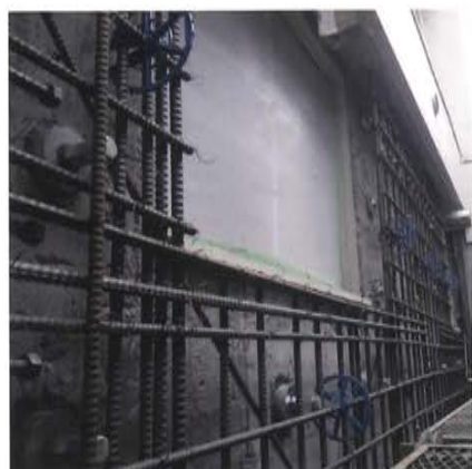
北側外壁増し打ち壁配筋
