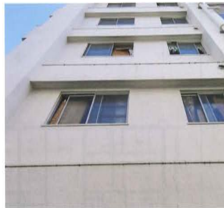
構造スリット新設 改修前
