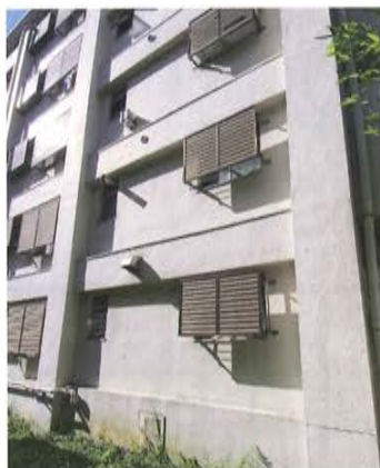
北側外壁増し打ち 改修前
