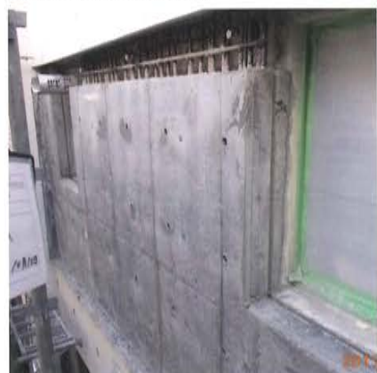
北側外壁増し打ち壁打設
