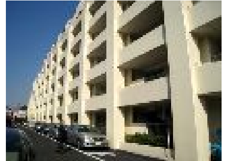
西側外観 足元にスペースがあった。外付けフレームによる補強を実施。
