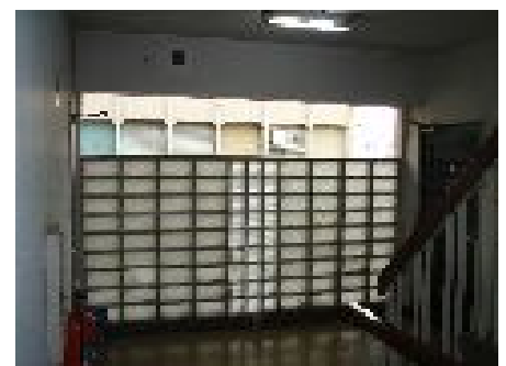
階段室：外壁ガラスブロック
