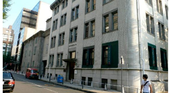
奥の部分が日本一古いRC建築物
