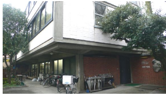
四ツ谷に佇む前川建築設計事務所ファサード
