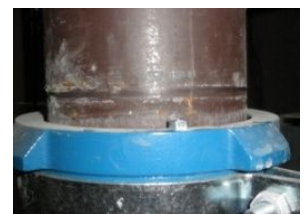
写真4 排水立管 単管が浮上がっている
