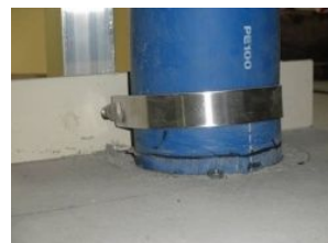
写真4 排水立管 単管が浮上がっている
