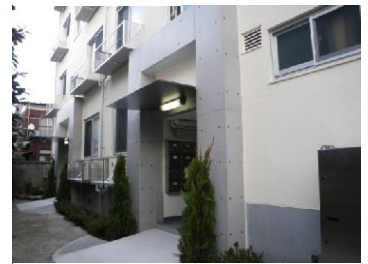
工事後(外付SRC造耐震フレーム)
