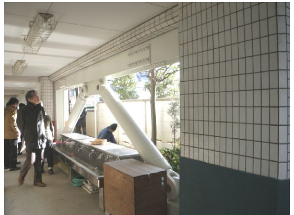
鉄骨ブレースの斜材を丸形にし、園児の安全性に配慮している。
