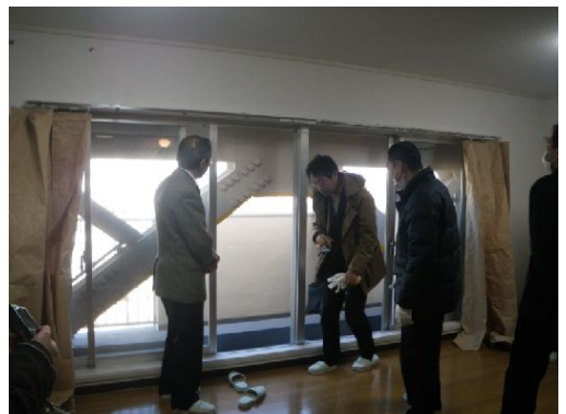
室内からバルコニー側のブレースを見る
