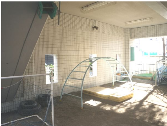
幼稚園の園庭に耐震壁を設置した箇所
