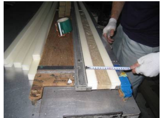
ロックウールにバックアップ材がセットされ耐震スリット材になる
