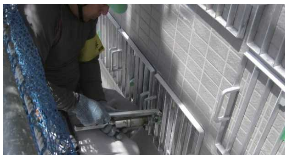
軽量で高剛性のアルミフレームを、タイル浮き部分に取り付けて補修材を注入する。浮きを上げず、目地の破壊を起こさず、浮き補修ができる、プレスタウングラウト工法。
