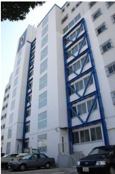
写真1 北側制震ブレース
