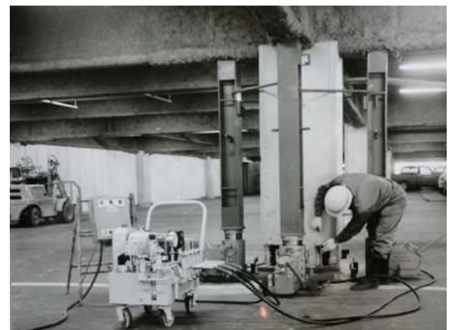
フローティング建物の嵩上げ作業状況
