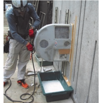
AWAT工法の施工
