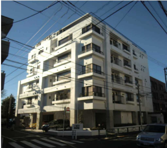
補強後の東北側外観
