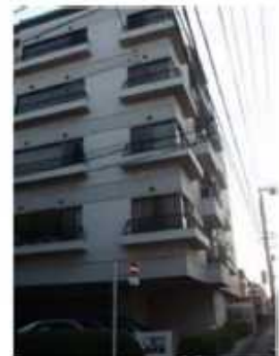
補強前東北側外観
