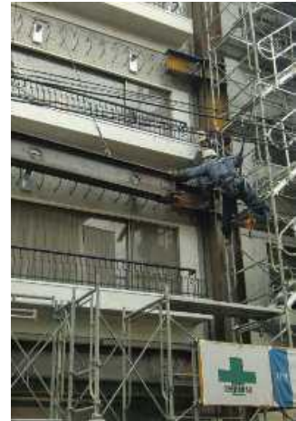
SRC補強フレーム鉄骨建方
