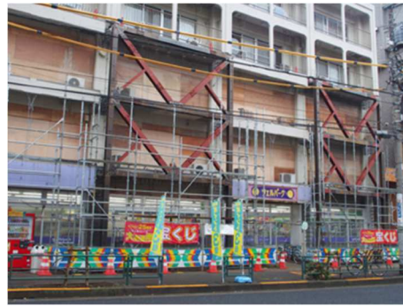
鉄骨の建て方完了、住戸の窓は完全に塞ぎ、2ヶ月ほど陽の入らない状態が続いた
