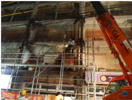
夜間の鉄骨建て込み工事
