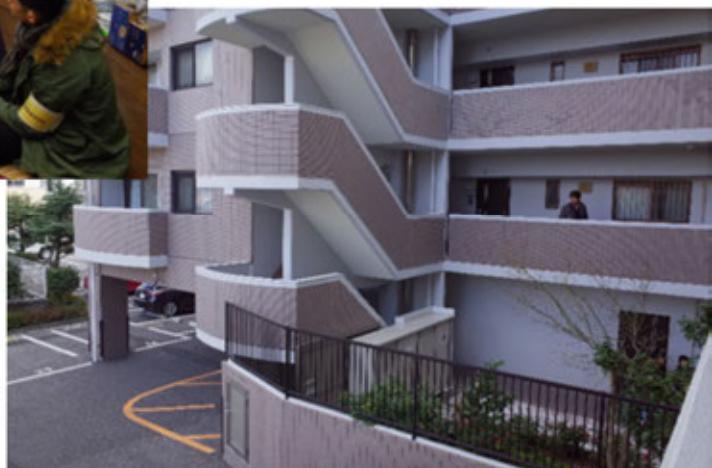
(右) 破損したタイルを張り替え、共用廊下側の外壁に生じた貫通ひび割れは、該当住戸は施工の為に一旦転居した上で、貫通損傷箇所の廻りに型枠等を設置しモルタルグラウト注入して補修。中庭に埋設されたガス管は、住民自らが掘削し施工会社の人手不足を補った。
