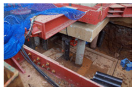
杭の補修工事の状況
