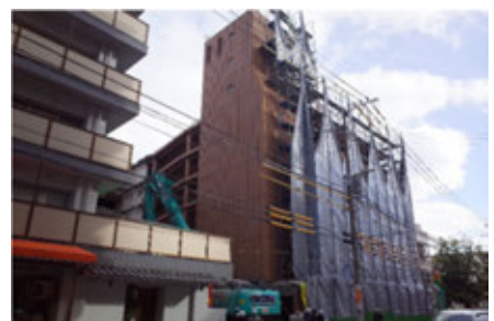
解体に着手した分譲マンション
