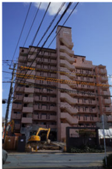
解体に着手した分譲マンション
