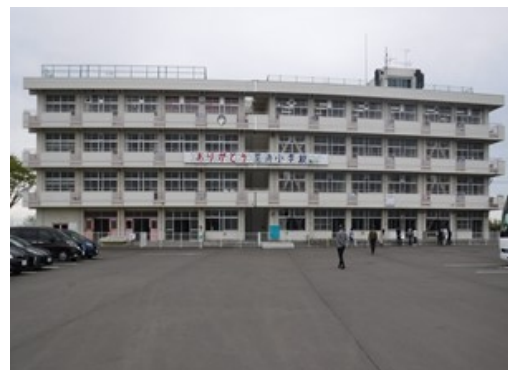
仙台市 荒浜小学校 遺構施設
