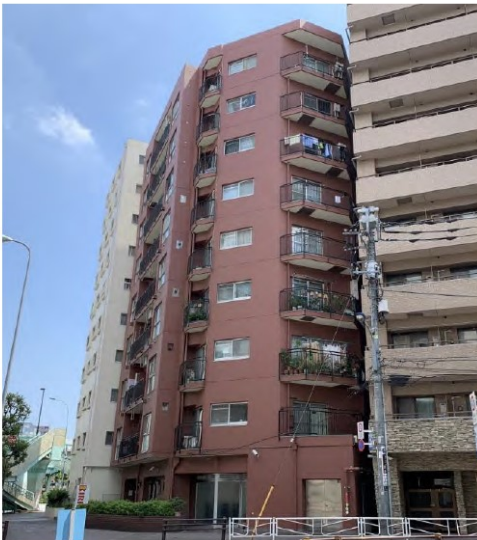
トーカンマンション王子 建物全景
