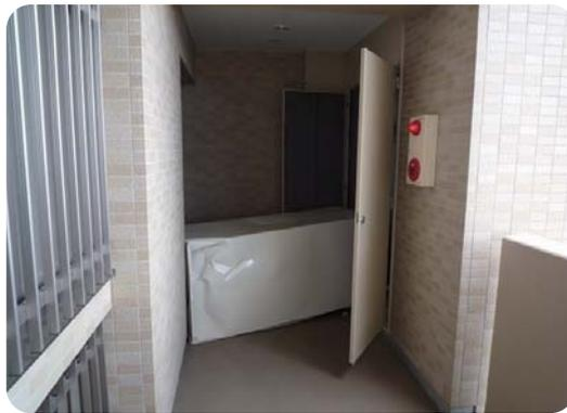
右：東日本大震災において転倒したマンションの電気温水器。完全に避難通路である共用廊下を封鎖してしまった。
