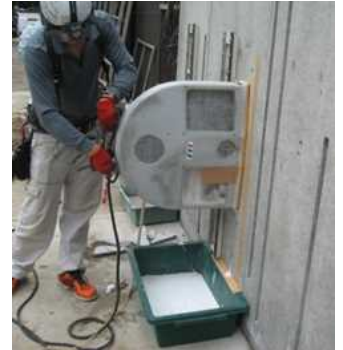
AWAT工法の施工
