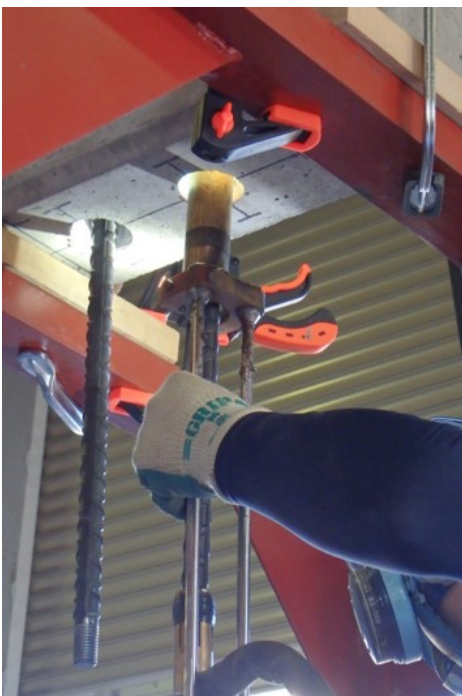
(左)上向き溶接 (モデル施工 の様子)
